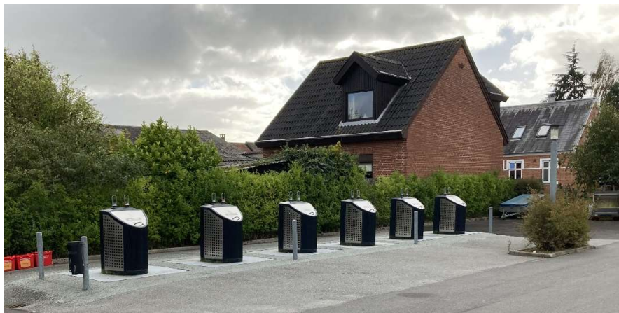
Figur 7 fælles renovation ved Behrendtsvej
