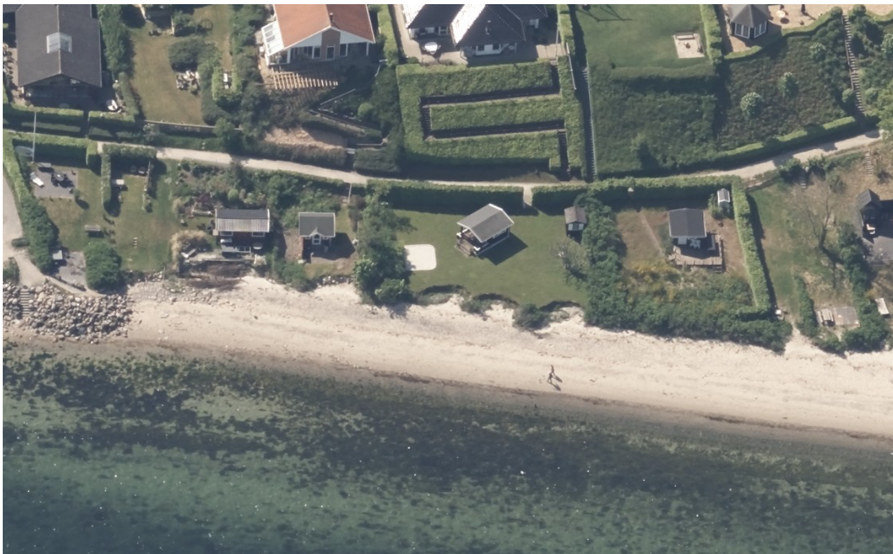
Figur 2: Skråfoto af de eksisterende anlæg.
