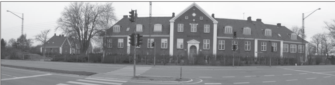
Det eksisterende bygningskompleks set fra Brovejen.
