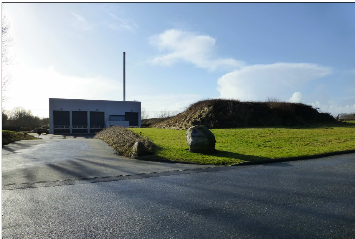
Det eksisterende fjernvarmeværk set fra Grandvej. Anlægget er delvist afskærmet af jordvold.
