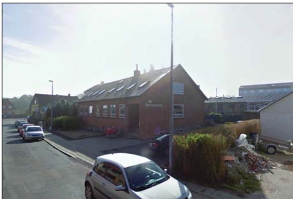
Den eksisterende bebyggelse i området, der hidtil har været anvendt til børneinstitution.
