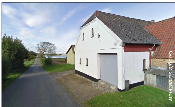
Fjernvarmeværket placeres bl.a. i dele af den eksisterende bebyggelse på ejendommen. I baggrunden ses Føns Vang Sø.
