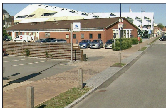
Havnegade (fra øst set mod lokalplanområdet).
