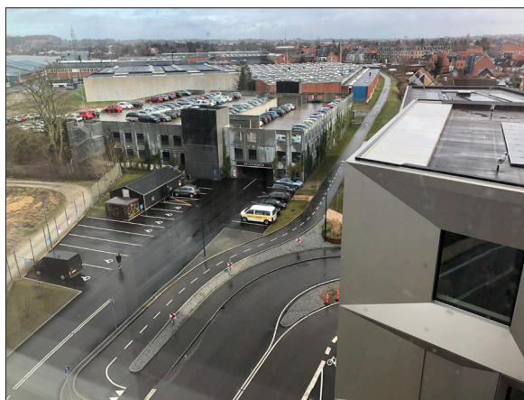
Indkørsel til området og P-huset fra Havnegade. Trafikhavnens bebyggelse ses i baggrunden.
