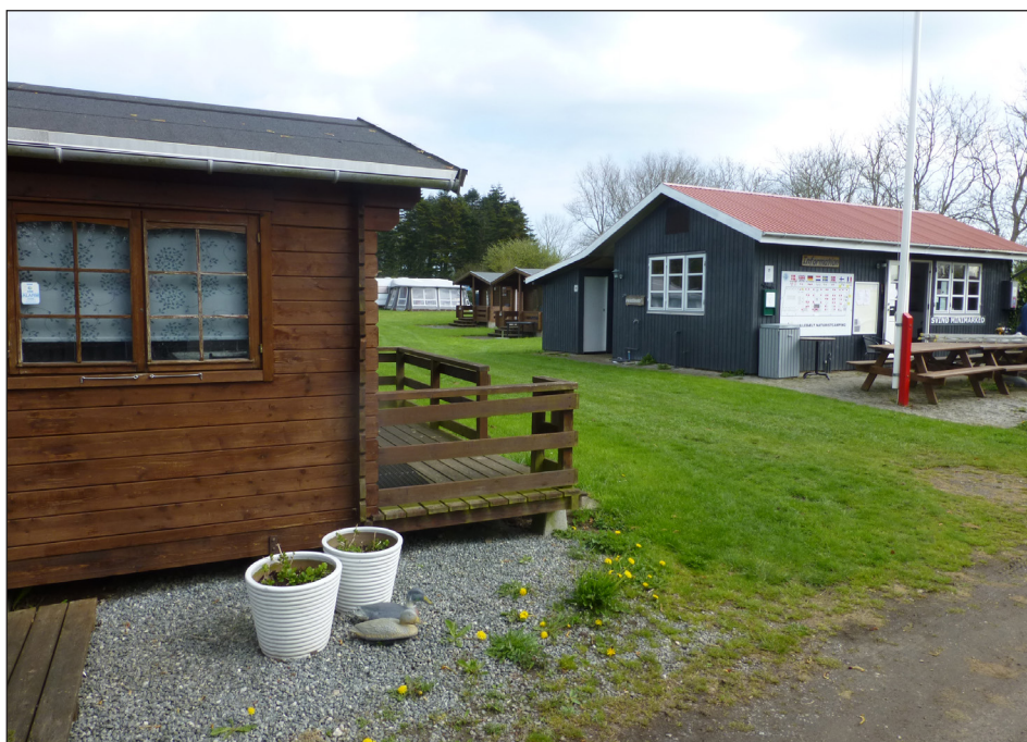
Eksisterende hytte- og servicebebyggelse i området. Nybyggeri skal udformes i tråd med den eksisterende bebyggelse.
