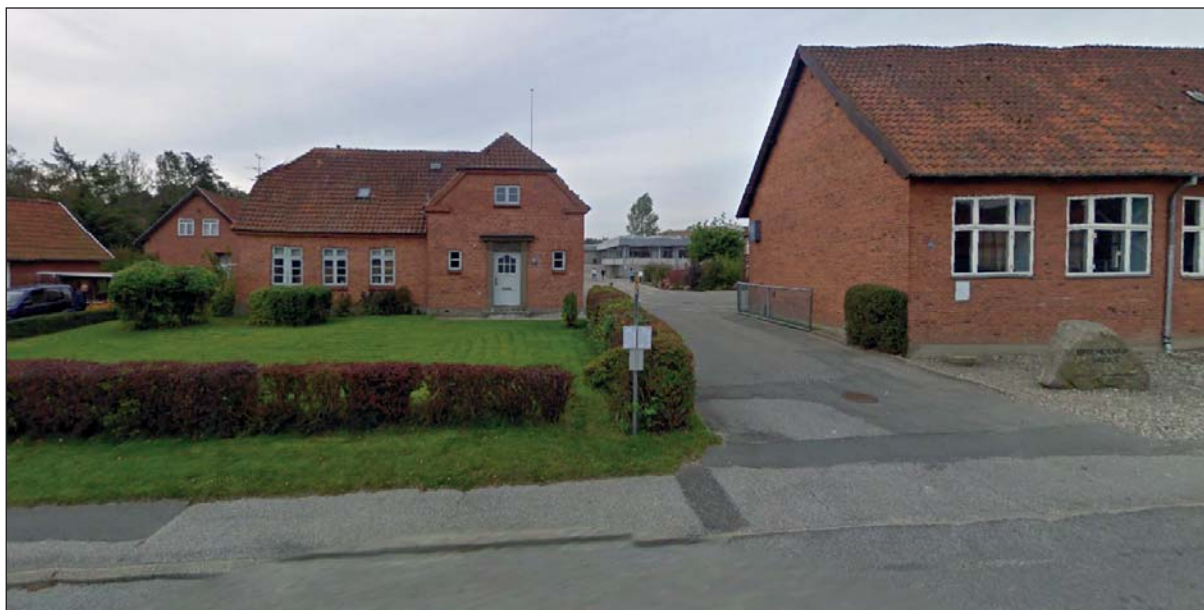
Tillæg 1's område med den eksisterende bygning set fra Kirkevej. Anna Trolles Skole og dennes indkørsel fra Kirkevej ses til højre i billedet (Google Streetview).
