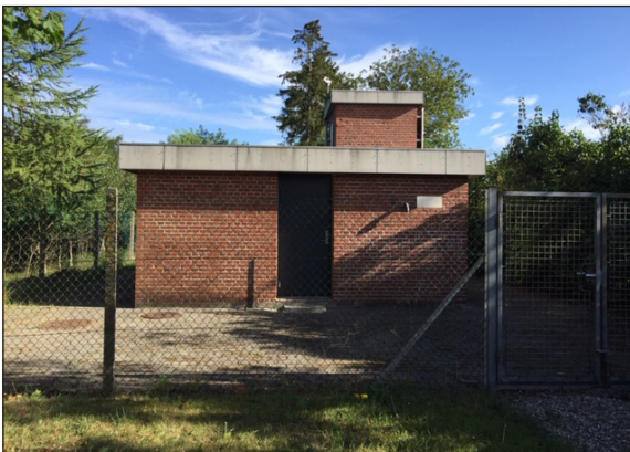
Den eksisterende vandværksbygning.
