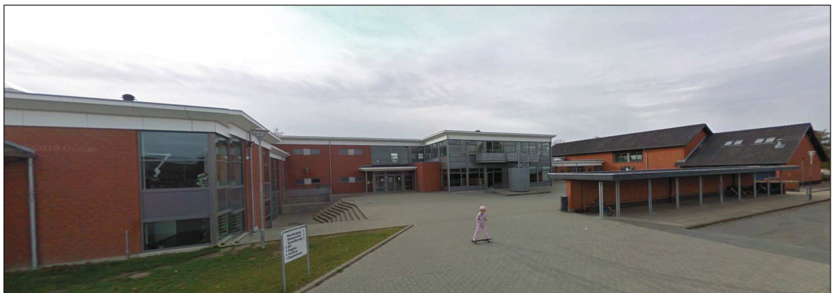
Hyllehøjskolen set fra skolegården. På billedet ses den nyere tilbygning i 2 etager.
