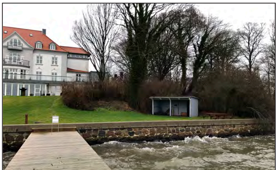
Figur 11: Foto, der viser eksisterende overdækning i haveanlægget.
