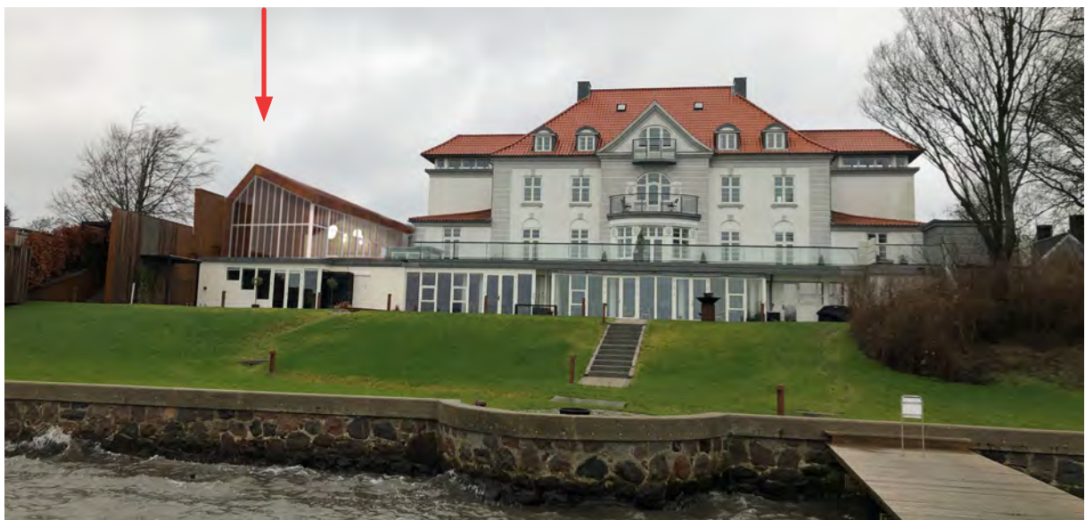
Fotostandpunkt nr. 2. Visualiseringen viser eksisterende bebyggelse og den del af den fremtidige bebyggelse. Ny bebyggelse er markeret med rød pil.
