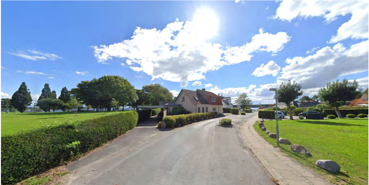
Fotostandpunkt nr. 5. Visualiseringen viser den eksisterende bebyggelse langs Teglgårdvej, herunder bebyggelsen der gives mulighed for at nedrive.
