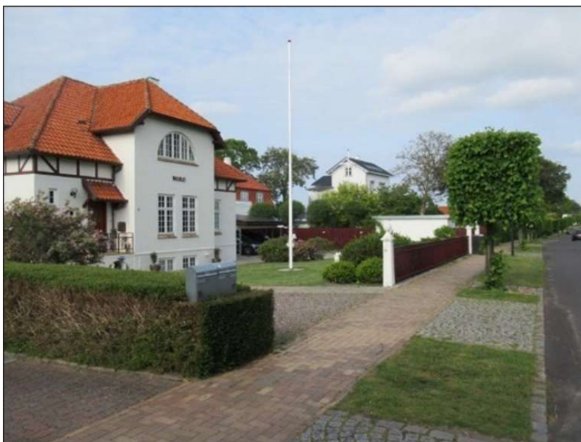
Figur 6 Eksempel på overgang mellem forhave og vejareal, med karaktergivende grøn forhave med lav hæk og lavt stakit, der giver god visuel kontakt mellem huse og gaderum.
