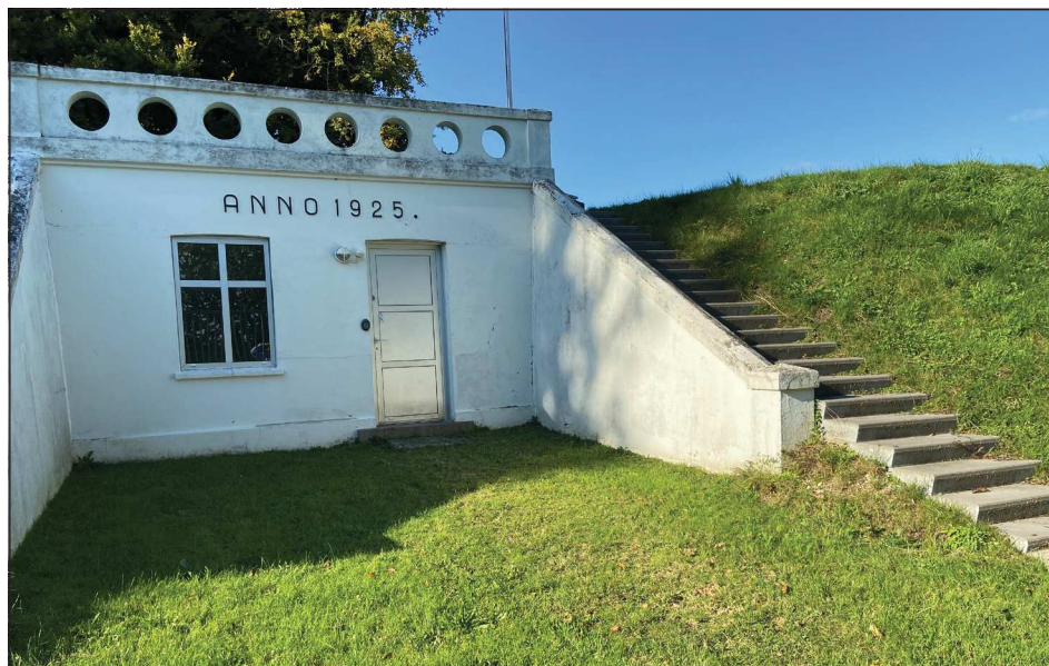
Billedet viser det eksisterende beholder anlæg.
