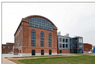
Figur 3: Den renoverede Turbinehal med tilbygninger.
