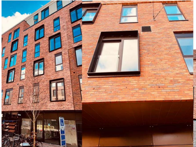
Figur 11 Referencebillede af vindue indrammet med stålprofil
