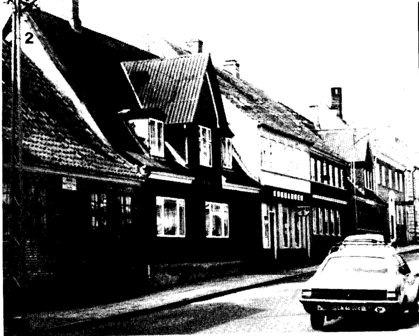
Algade nr. 14 og 16 før
