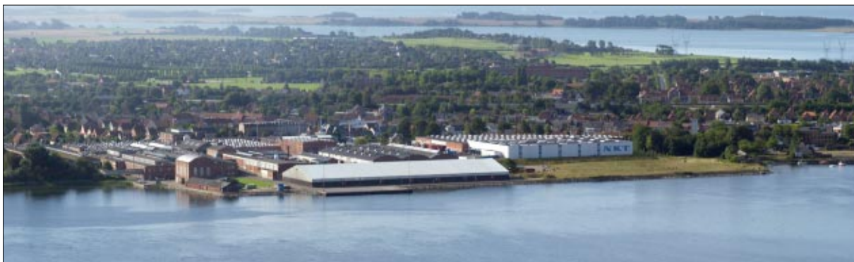
Eksisterende forhold i området set fra Lillebæltsbroen.
