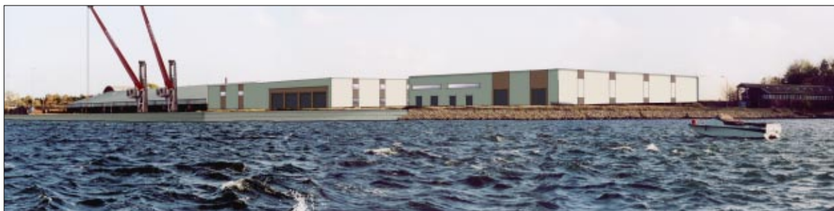
Indpasning af nyt kaj anlæg samt eksempler på nye erhvervsbygninger i området set fra Lillebælt.
