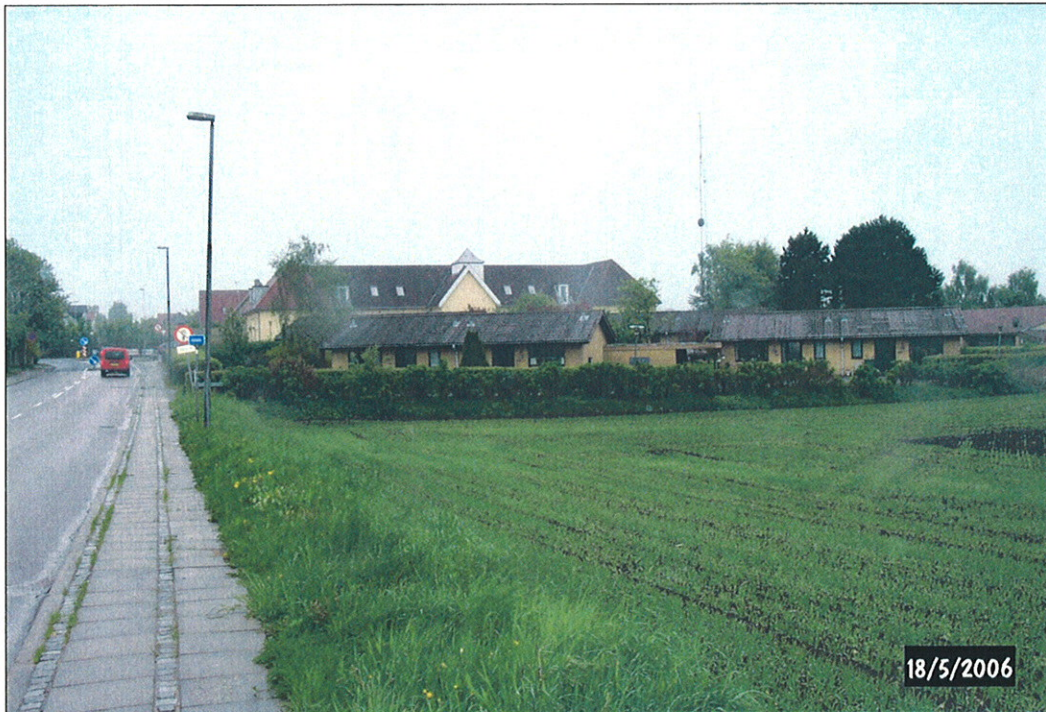
Figur 1 Den eksisterende bygningsmasse har været bygget til og har været anvendt til boliger.
